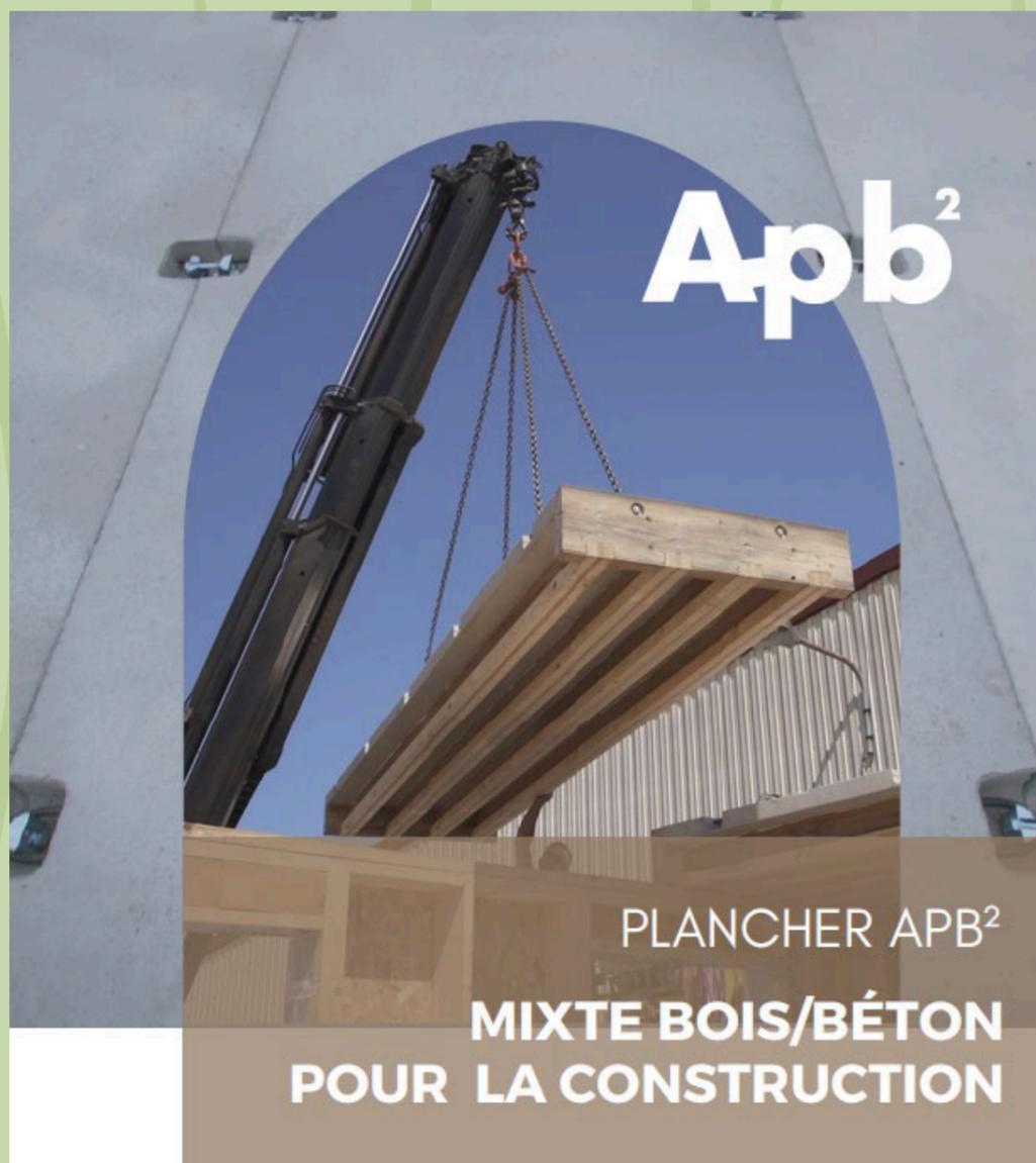
L'idée de leur produit est de **prendre les qualités intrinsèques** de chacun des deux matériaux, le **béton** en compression (point faible du bois) et le **bois** en flexion (point faible du béton), et de **les combiner**.
